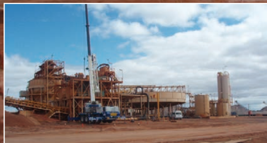
ジルコンサンド精製工場。ここで原鉱から数種類の工程を経て、ジルコンサンドのみを抽出します。
